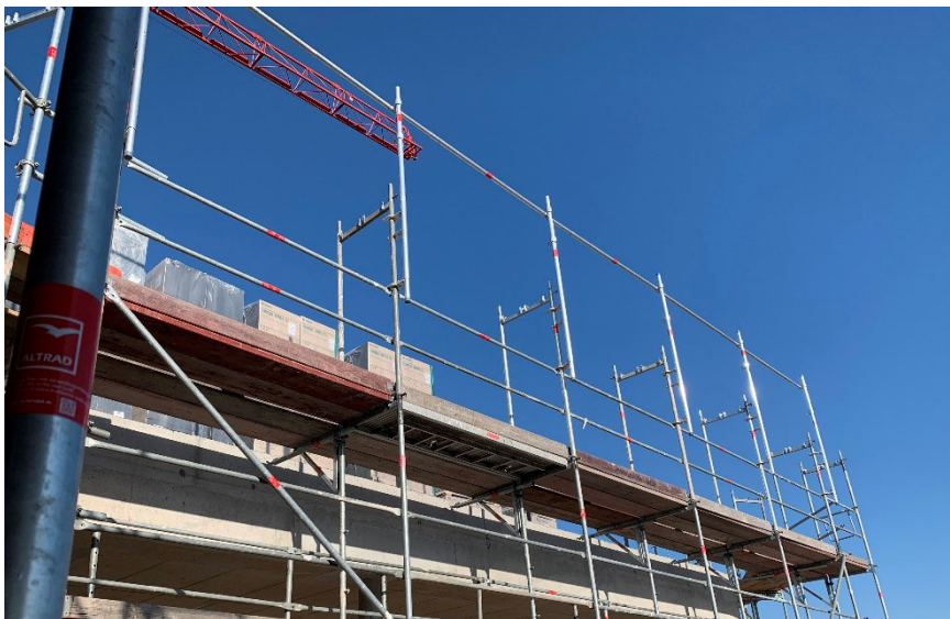
BU: Vorlaufendes Montagesicherheitsgelenk im Einsatz
